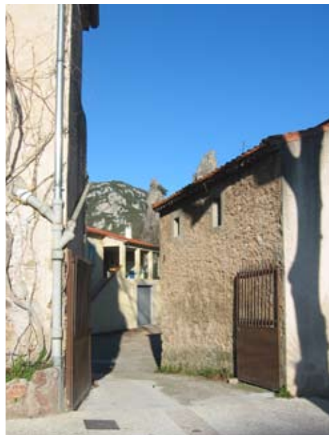
Le bâtiment, depuis le portail de sa cour de service.
