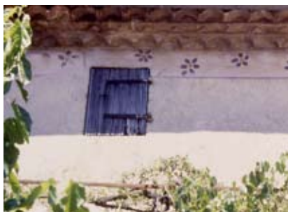
Le débord de toiture protège les façades des intempéries. C'est le rôle que jouent les génoises dans la traditionnelle maison en pierre de la région.
