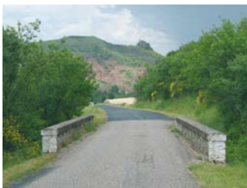
Des murs en pierre couronnés d'un chaperon
