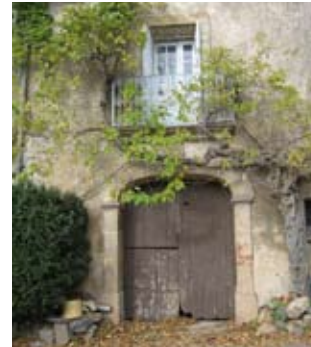
Des porches, des portes ...
