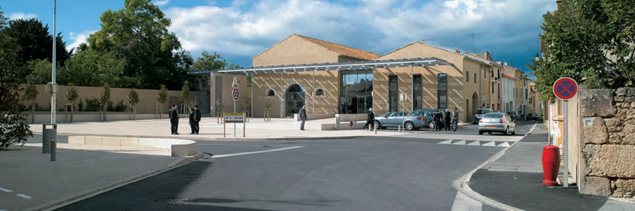
L'équipe d'architectes Boyer-Percheron-Assus lauréate de ce concours a livré le bâtiment en 2009.
