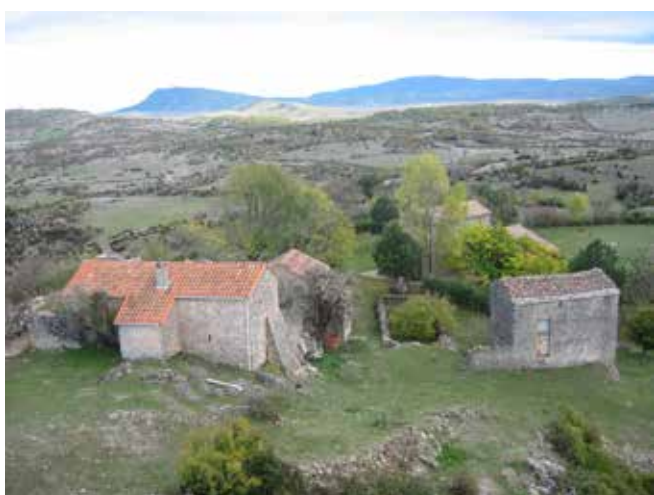
Belfort commune de Blandas: Dans ce hameau moins accessible, l'aspect des constructions est plus rustique, avec peu d'ouvertures. Les bâtiments s'adaptent au terrain, se resserrent et se regroupent par unité de propriété. Les murs sont en pierre apparente destinées à ne pas être enduit dès la construction.
