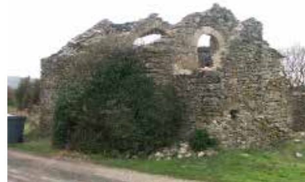
Un bâtiment du Mas de la Roque à Saint Etienne de Gourgas
