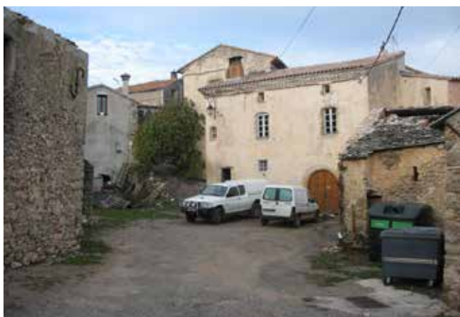
La Rigalderie commune de Blandas: Murs en pierre avec un enduit au mortier de chaux pour les bâtiments principaux. L'alignement des baies plus hautes que large et décroissantes du rez-de-chaussée au dernier niveau compose la façade.
