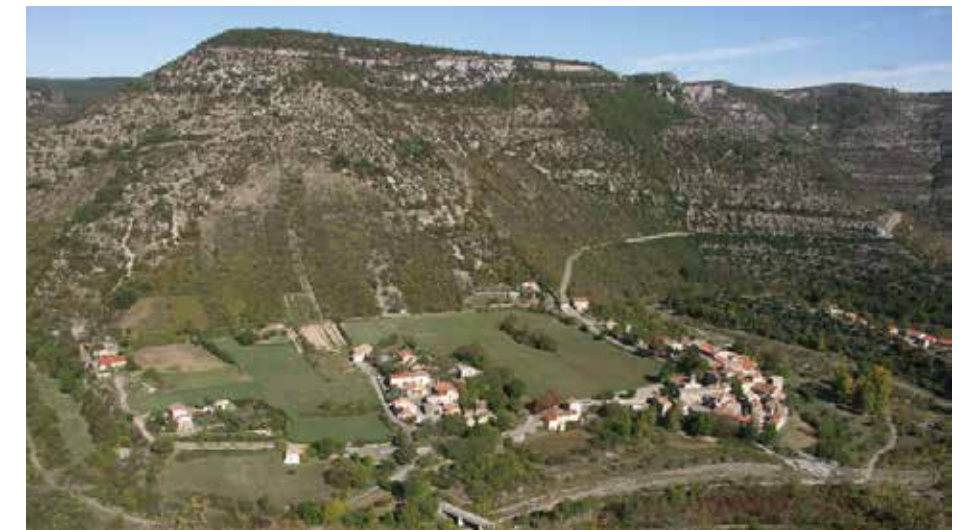
2- Commune Vissec: Point de vue sur le village et la vallée amont de la Vis depuis le sud
