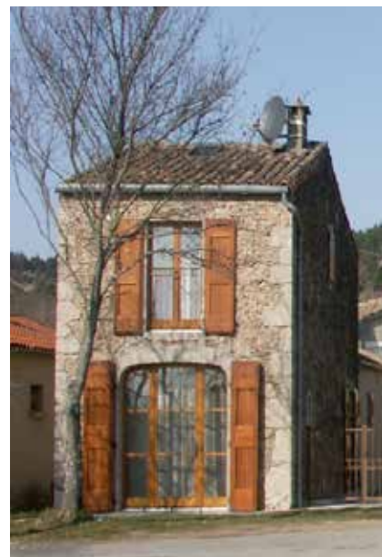
Baie charretière transformée à Blandas
