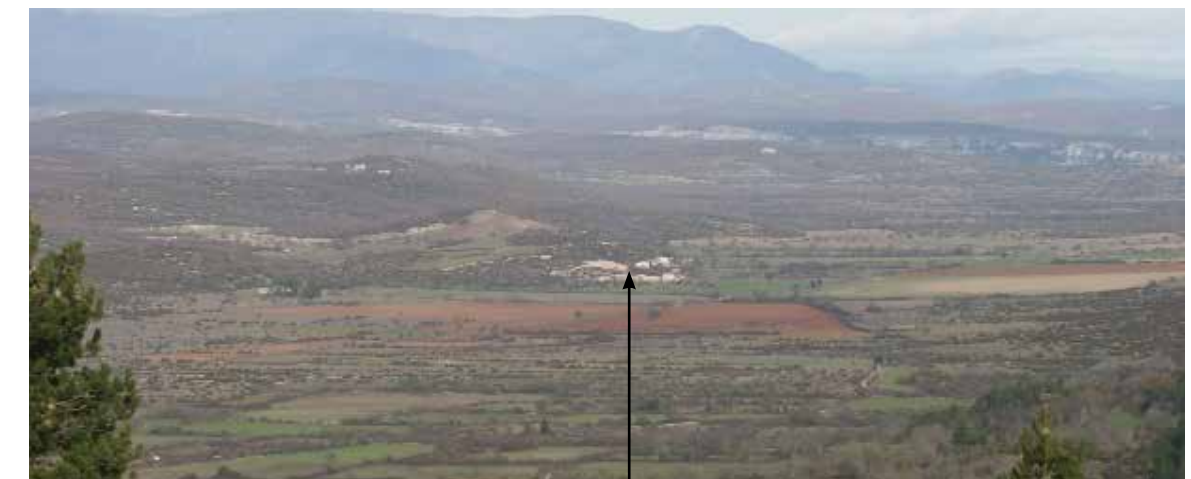
Des terrassements visibles et des constructions aux façades trop claires créent un point d'attraction dommageable pour la perception générale de la plaine
